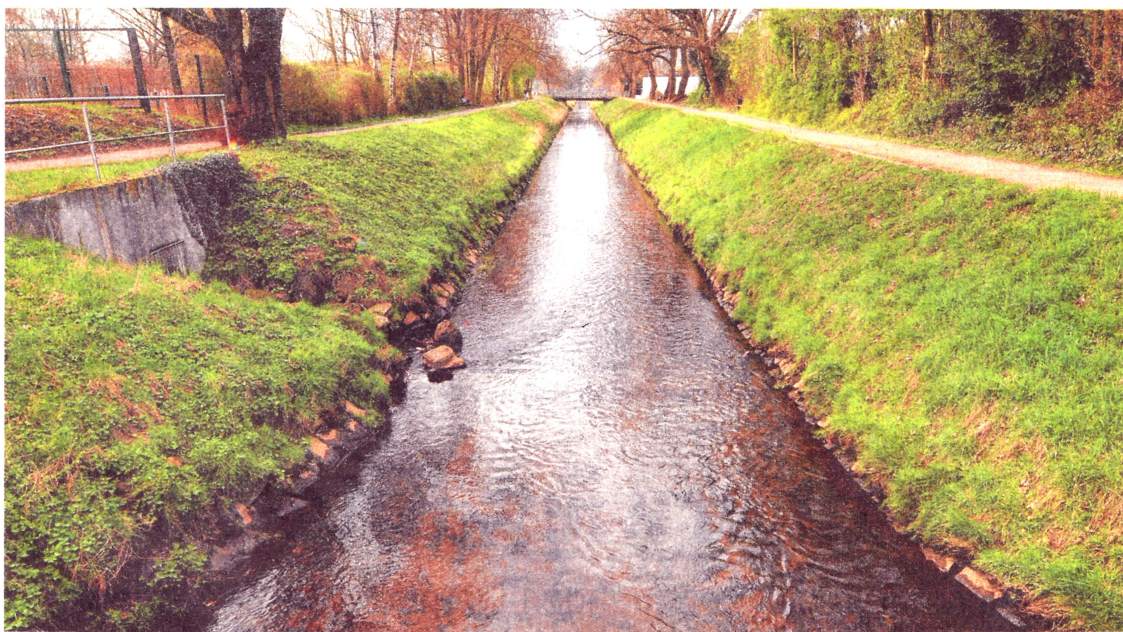
Der schnurgerade Rotbach soll sich nach der Umstrukturierung von der B8 bis Voerde schlängeln.
