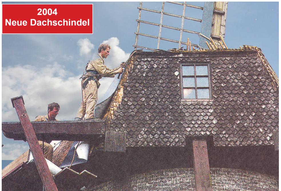
Ein Rest der vom Alter geschwärzten Schindeln ist auf dem Mühlendach noch zu sehen. Ungleichmäßiges Gehämmert tönt herab und zeugt davon, dass dort oben gearbeitet wird. Unten am Boden häufen sich kleine Berge von spröden Holzsetzen: Die verwitterten Überreste der alten Schindeln aus Eichenholz. Die Renovierungsarbeiten laufen seit Mitte Juni nach Plan, das Dach ist schon zur Hälfte frisch gedeckt.
